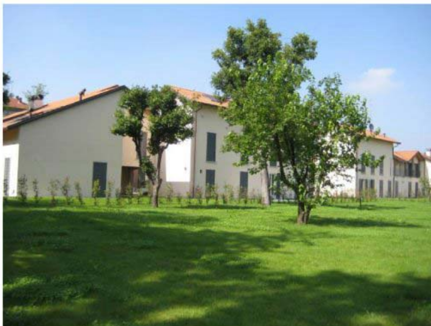
La cascina Cappelletti dopo la ristrutturazione
