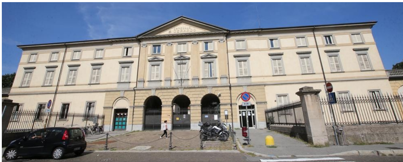
La facciata dell'Ospedale Vecchio
